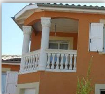
Type de balustres interdites
