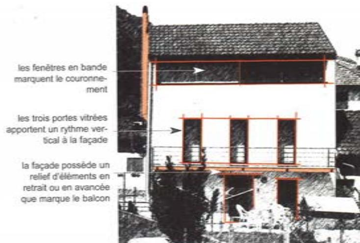
des enduits à la chaux permettent une nouvelle partition des façades
